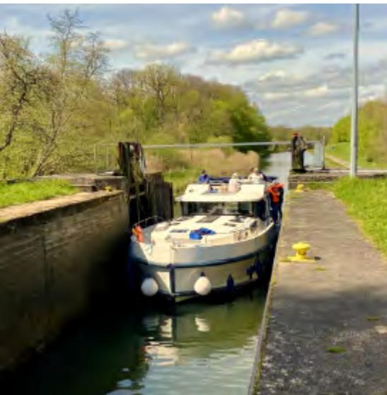
zweigt bei Gondrexange vom Marne-Rhein-Kanal ab und verbindet diesen mit der kanalisierten Saar bei Sarreguémines. Der Höhenunterschied wird auf den 65 Kilometern Länge über 27 Schleusen ausgeglichen. Streckenweise sind diese nur wenige hundert Meter voneinander entfernt, sodass man beim Passieren schon die nächste Schleuse sehen kann. Einst diente der Saarkanal dem Transport von Kohle, heute sind auf ihm vor allem Freizeitkapitäne unterwegs.
