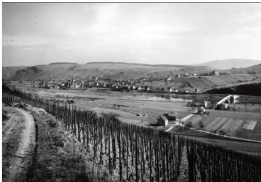
Wiltingen, Dädiwwer, erste Brücke
