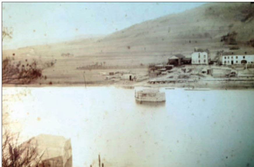
Seltenes Bild vom Bau der ersten Brücke: 1912, die Pfeiler in der Saar stehen bereits.
